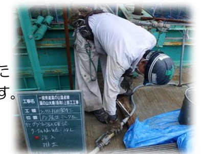
グラウト注入状況
