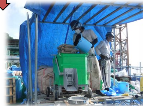
グラウト材練り混ぜ状況
