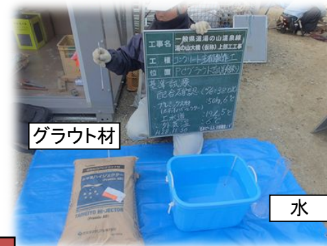
グラウト材配合確認状況
