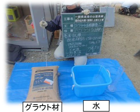
グラウト材配合確認状況
